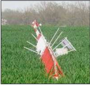
Les haubans du mât de mesure des vents ont été sectionnés, faisant basculer la tour.
