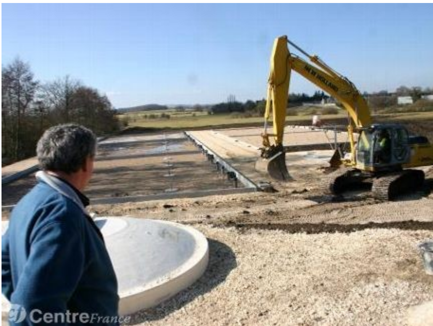
TRAVAUX : La nouvelle station d'épuration d'Entrains-sur-Nohain a été au coeur de la problématique engendrée par l'intégration de la commune de Michel Paquette au sein de la communauté de communes du Val du Sauzay
