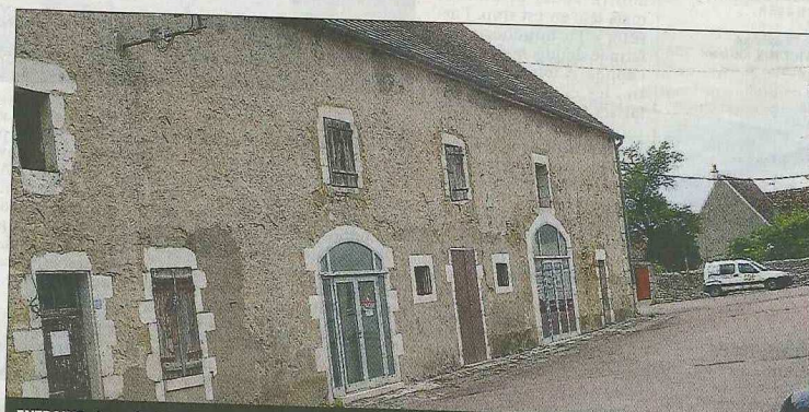
ENTRAINS. La maison Denizon, rue du Petit-Fort, va être acquise par la Communauté de communes du val du Sauzay, qui va y installer une maison des services, annexes de ceux installés à Varzy. PHOTO D'ARCHIVES
